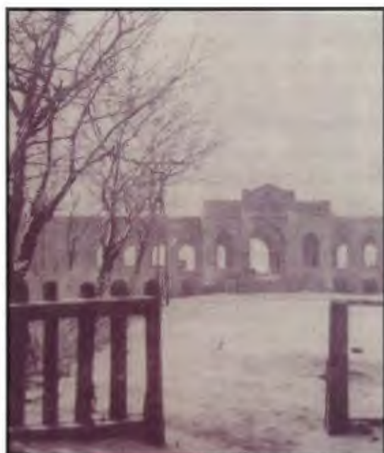
Stazione ferroviaria di Cerkovo
